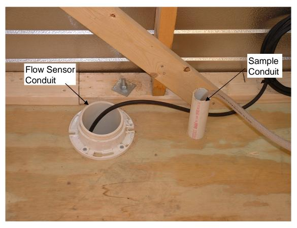
f. Sample and Sensor Cable Conduits
